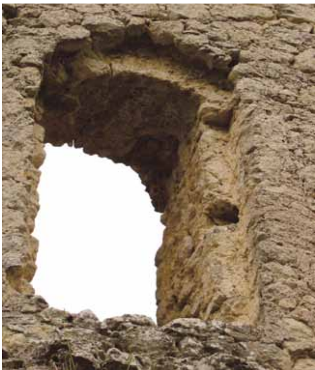
22 Gračanica, ulazna kula, izlaz na branište s II. kata – pogled izvana (foto: R. Ivanušec)
