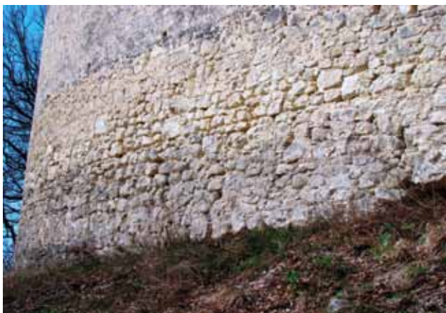
42 Istočni obodni zid – zidanje u tzv. horizontalnim pojasevima (foto: R. Ivanušec)
