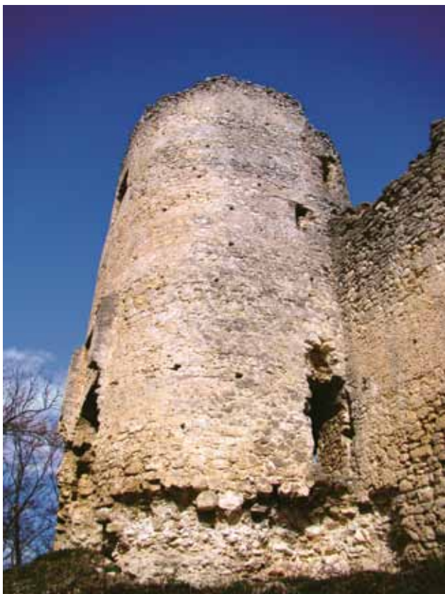
40 Ulazna kula – pogled s jugoistoka, stanje 2010. prije radova građevinske sanacije (foto: R. Ivanušec)
