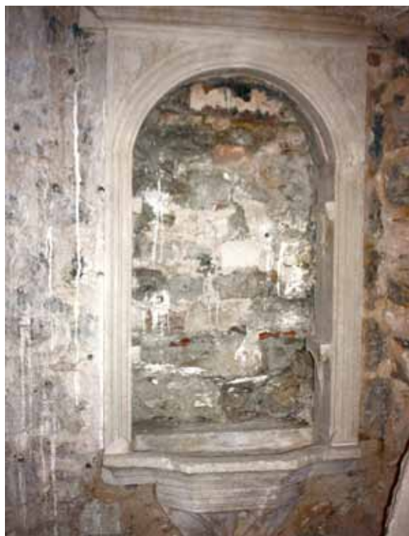
25 Palača Užižić (Hektorović), Groda, k.č.zgr. 74/11 k.o. Hvar, stanje tijekom radova sanacije (foto: A. Gamulin)
