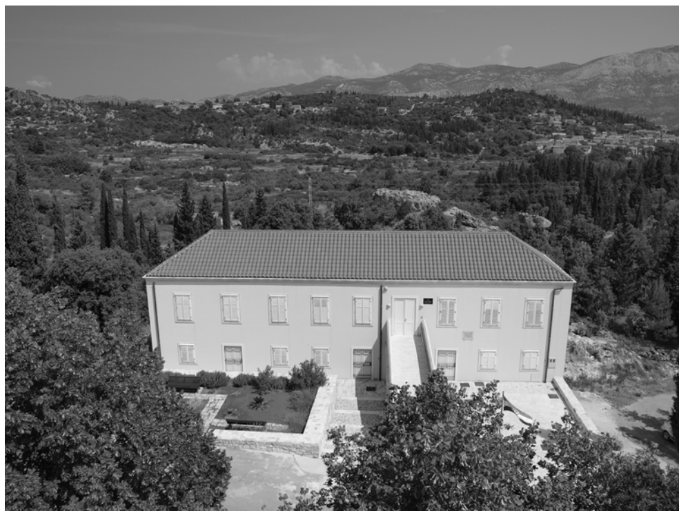
Slika 1. Zgrada Arhivskog sabirnog centra (foto Neven Fazinić 2011.)
