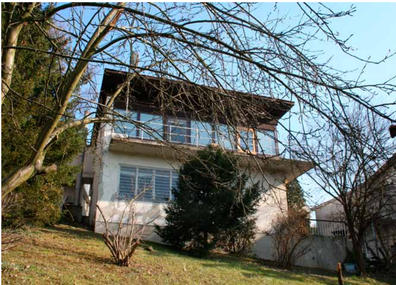
15 Zapadno pročelje kuće Kreneis-Horvat na Vijencu 6, 2009. godine (fototeka Z. Paladino) West facade of the Kreneis-Horvat house on Vijenac 6, 2009 (photo archives of Z. Paladino)
