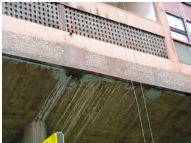
17 Vukovarska 35-35 a, detalj pročelja prije obnove, kosina pogleda prizemlja, (foto: J. Šćavničar Ivković)
