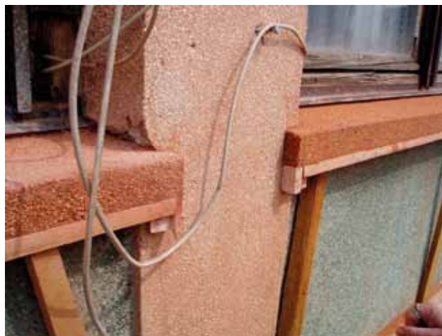
25 Vukovarska 35-35 a, saniranje dijelova zida od obojenoga prano kulira (foto: J. Ščavničar Ivković)
