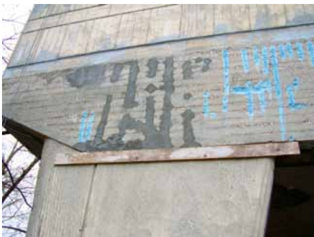
22 Vukovarska 35-35 a, sanacija armature betonskih zidova (fototeka GSKG-a)
