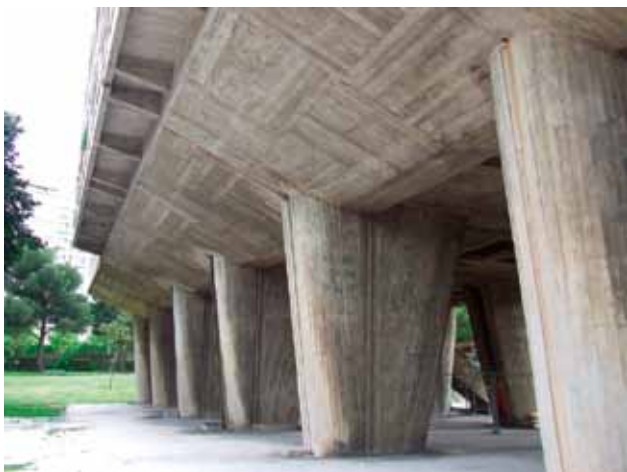
3 Unité d'Habitation, u Marseilleu, prizemlje, (preuzeto s: http://www.marseillecar.com ) Unité d'Habitation, in Marseille, ground floor (taken from: http://www.marseillecar.com )
