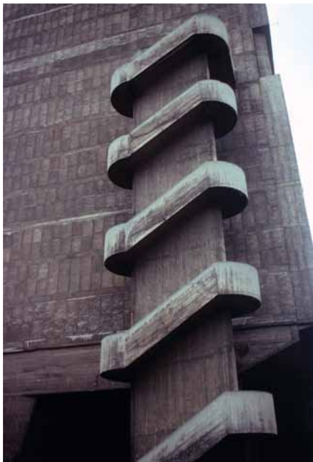
7 Unité d'Habitation, u Marseilleu, bočno pročelje Unité d'Habitation, in Marseille, lateral facade
