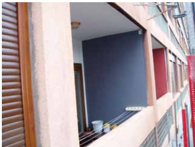
26 Vukovarska 35-35 a, bojenje žbukanih zidova balkona (foto: J. Ščavničar Ivković)
