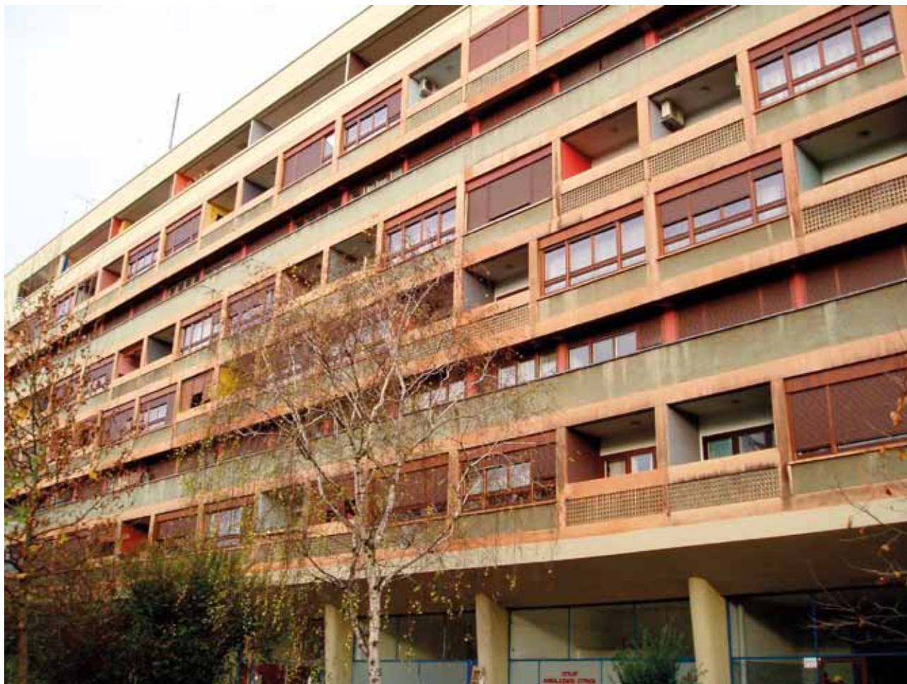
34 Vukovarska 35-35 a, južno pročelje nakon završetka radova (foto: J. Šćavničar Ivković) Vukovarska 35-35 a, southern facade after the completion of works (photo: J. Šćavničar Ivković)
