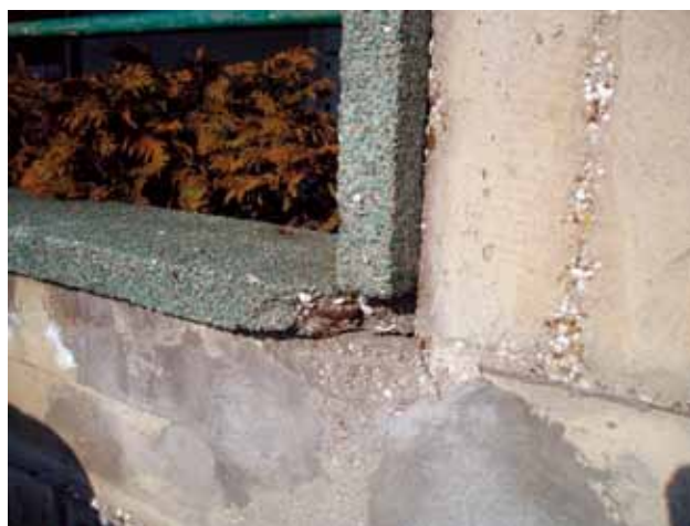
16 Vukovarska 35-35 a, detalj pročelja prije obnove, VII. kat, (foto: J. Ščavničar Ivković)
