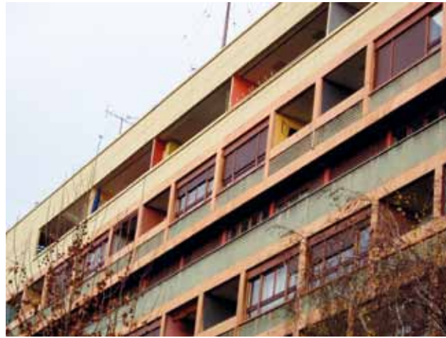
27 Vukovarska 35 – 35 a, detalj obnovljenoga južnog pročelja (foto: J. Ščavničar Ivković)
