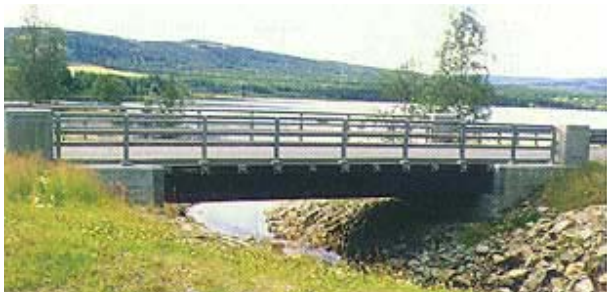
Slika 7. Grylla drveni gredni cestovni most
