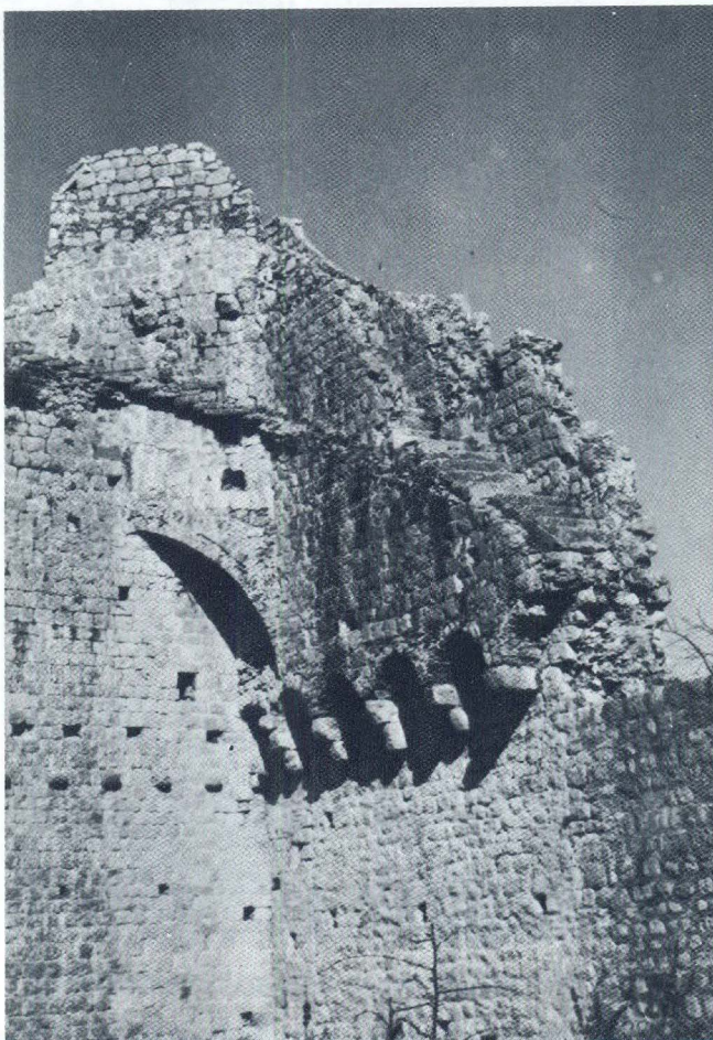
Unutrašnjost sjeverozapadnog ugla tvrđave Korune
