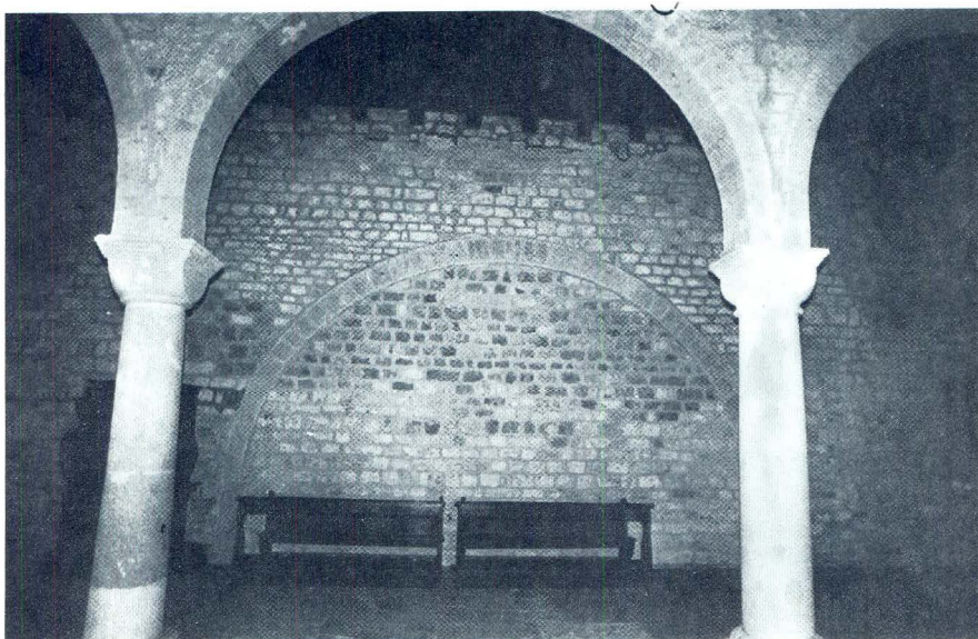
Krk, sv. Kvirin, gornja crkva, pogled prema istoku, zazidan otvor prema katedrali
