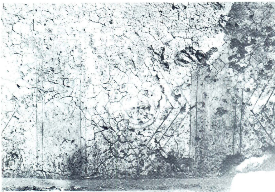
Lovrečina, detalj freske na istočnom zidu južnog dijela transepta
