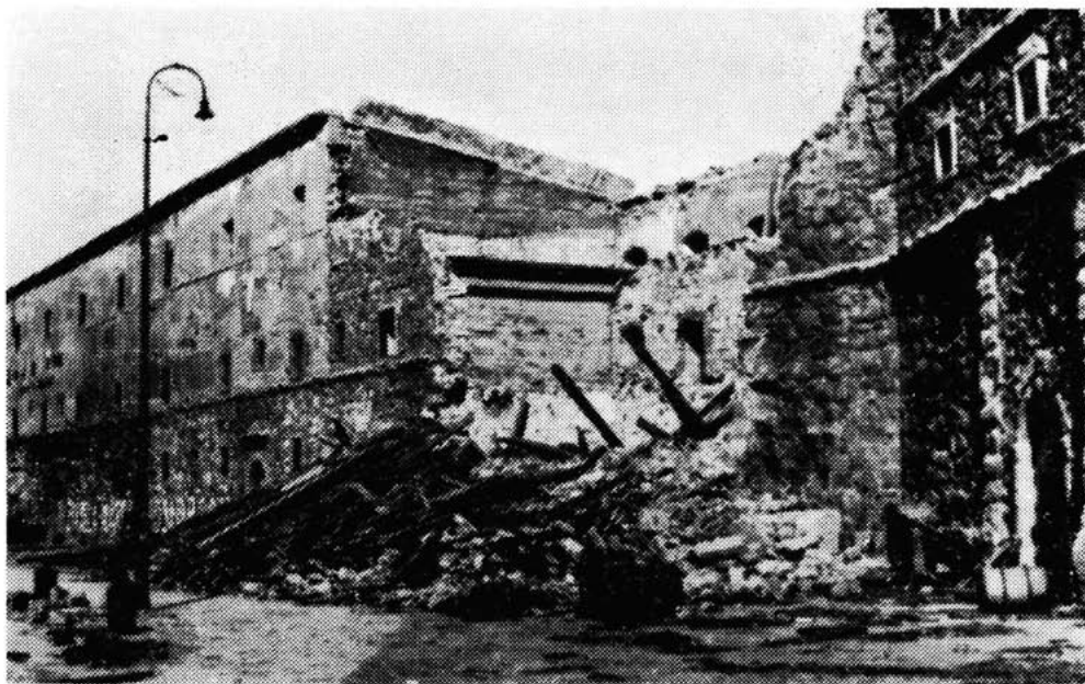
Sl. 65 — Porušeni i spaljeni stari »Carski magazini« na senjskoj obali 1943.
