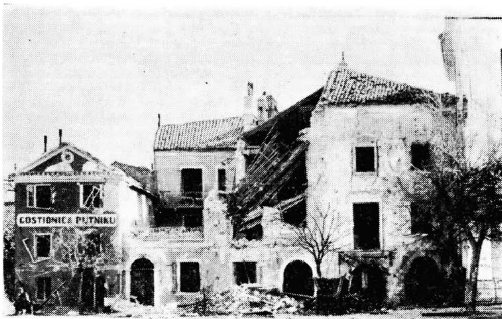
Sl. 66 — Porušene kuće na senjskoj obali 1943.
