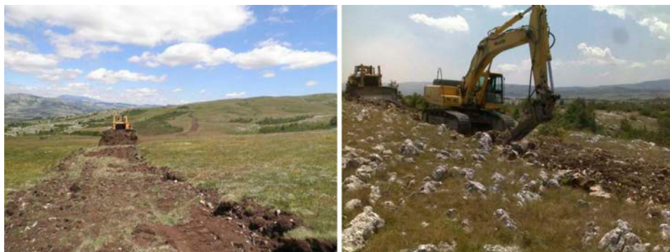
Slika 18. Građevinsko trasiranje pristupnih putova.
