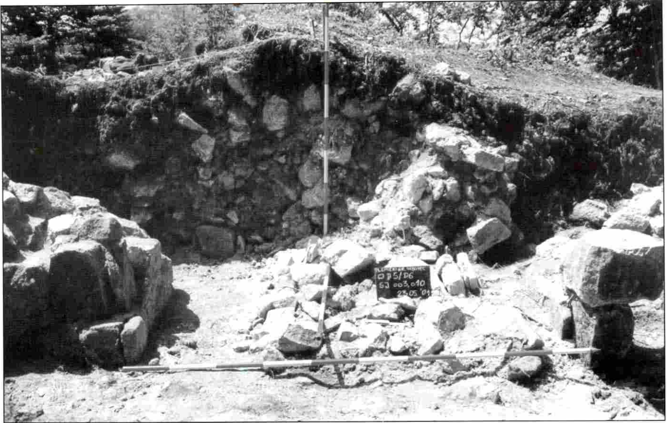
Sl. 20. Sjeveroistočna dvorana: urušeno stubište SJ 010 (pogled s istoka)
