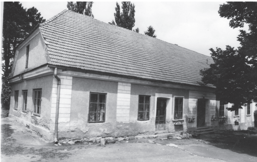
Školska zgrada u Breznici, snimljeno 1973. godine
