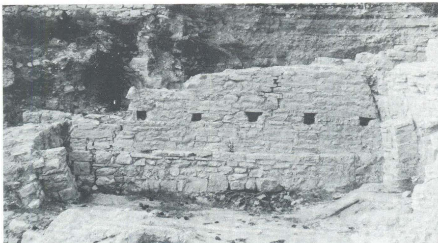
Pogled na sjeverni zid cisterne u Bolu
