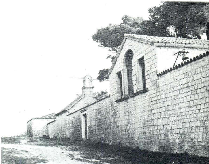
Sjeverno pročelje Kašteleta nakon obnove
