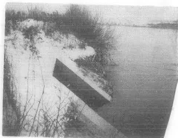
Sl. 8. Novi kolektor za otpadne vode južnog Zagreb
