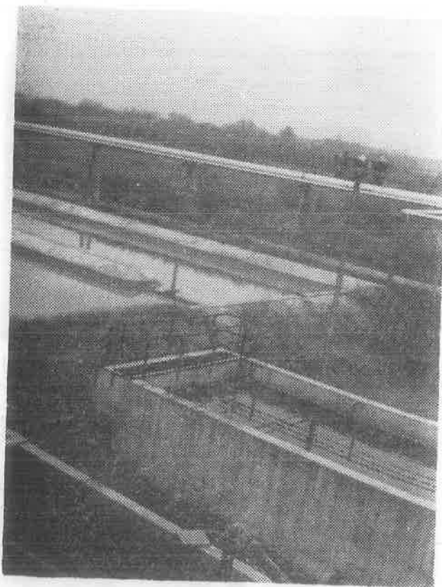
Sl. 5. Dio bazena za taloženje aktivnog mulja.
