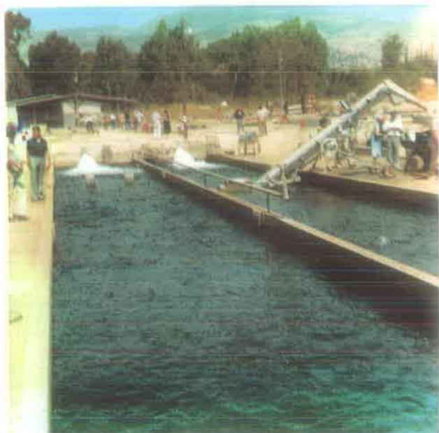
Detalj bazena na pastrvskom ribogojištu Dan
