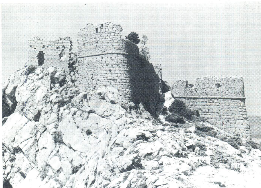
Dio gotičkog zida sa zazidanim kruništem i kasnorenesansni bastioni tvrđave Starigrad
