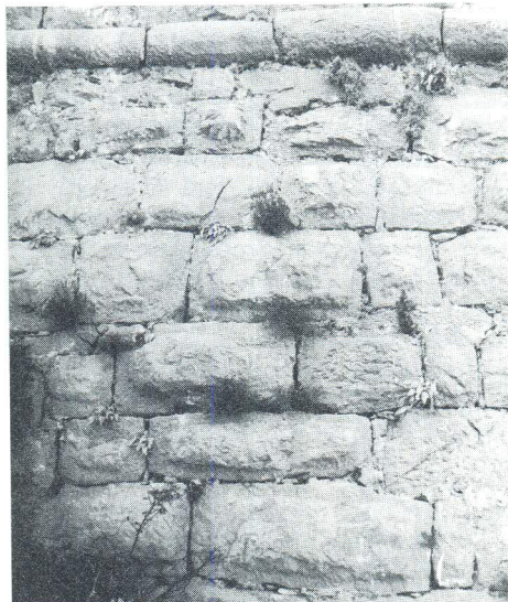
Detalj skarpe bastiona zidan blokovima bunja tvrđave Starigrad
