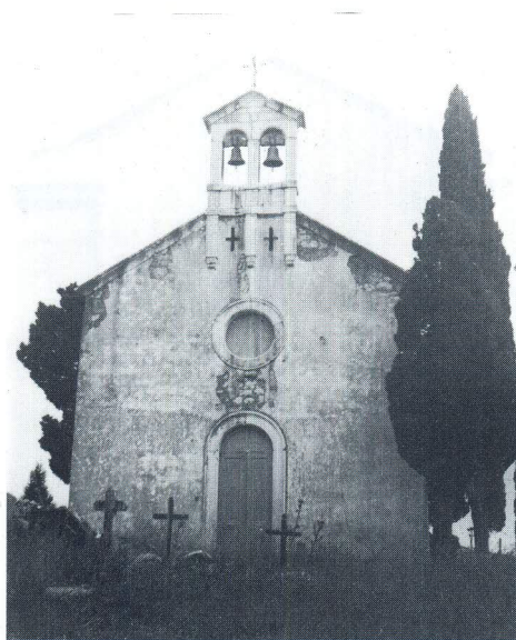
Polače, crkva sv. Kuzme i Damjana, pogled na glavno pročelje, 1836. g.
