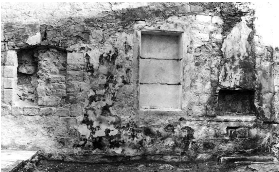
Slika 13. Pogled na južni zid palače sa zidnim ormarima i ognjištem
