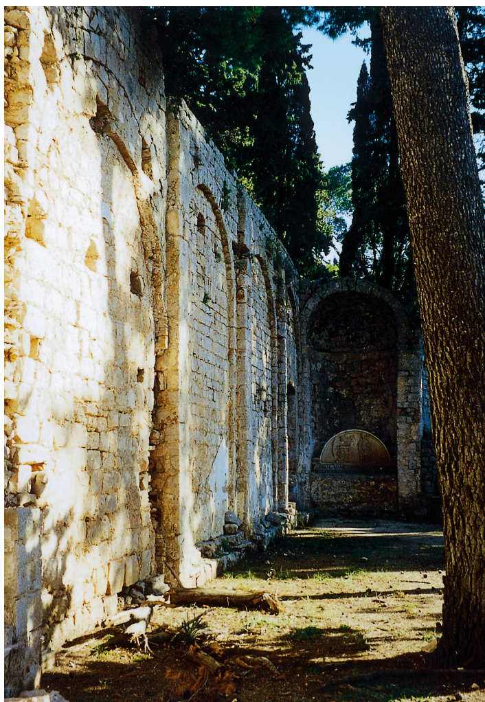
Slika 4. Unutarnja strana sjevernog zida crkve
