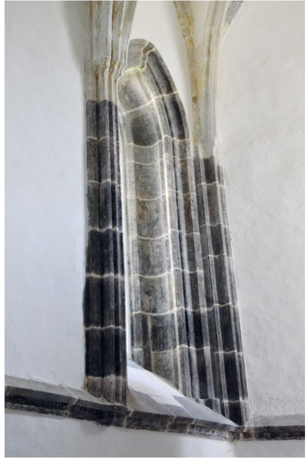
12. Kapela Sv. Trojstva, monofora u južnoj kapeli nakon obnove (fototeka HRZ-a, snimio D. Miletić)
