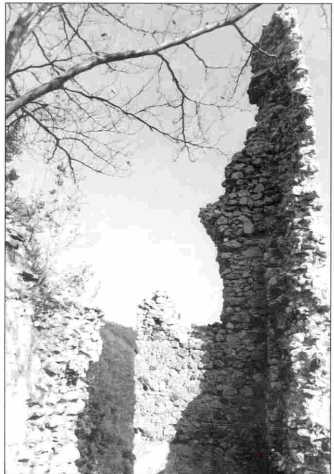
Slika 12. Ulazni prostor južne prigradnje u pogledu sa zapada (D. Miletić, 1993.)
