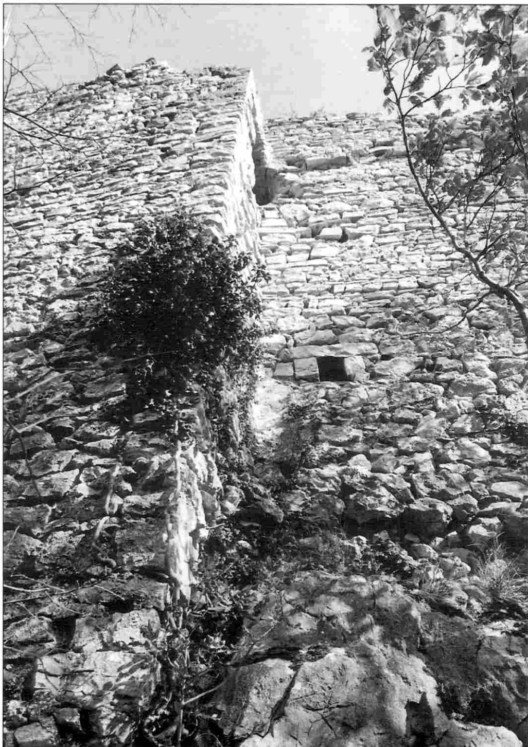
Slika 16. Pogled izvana na istaknuti dio i otvore zapadnog obrambenog zida (D. MILETIĆ, 1992.)
