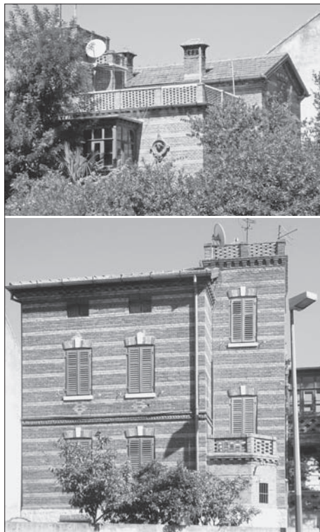
SL. 10. VILA ARHITEKTA AUGUSTA THARE, GRAĐENA 1870-IH, POGLEDI S JUGOISTOKA I ZAPADA
