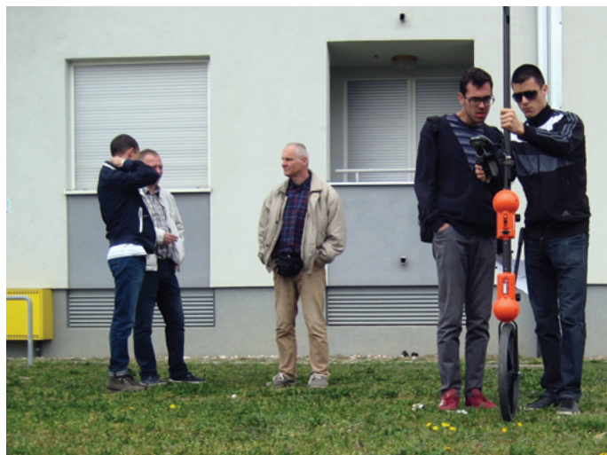
Slika 16. Traganje za podzemnim instalacijama na travnjaku ispred stambene zgrade
