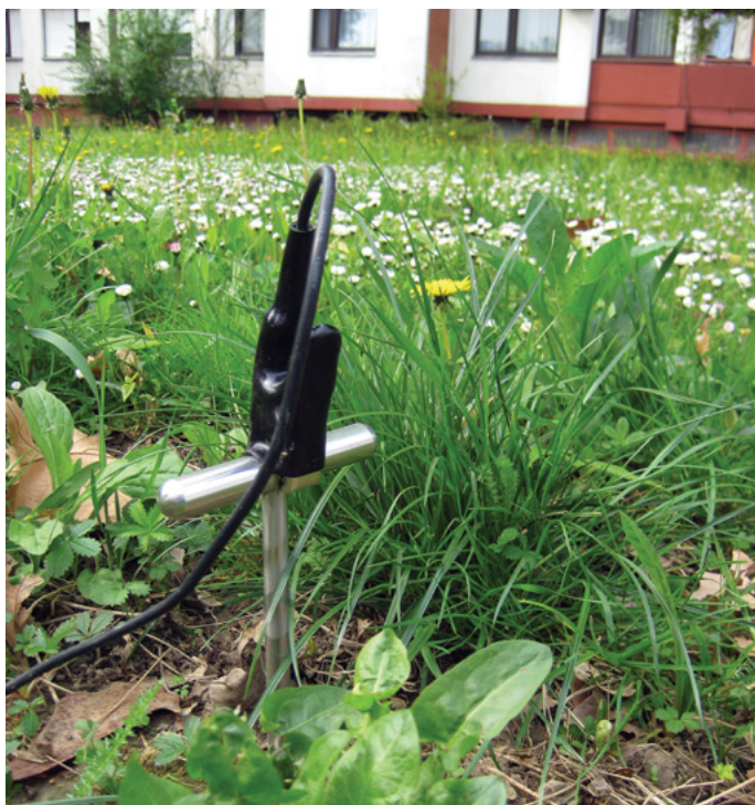
Slika 10. Spoj na uzemljenje
