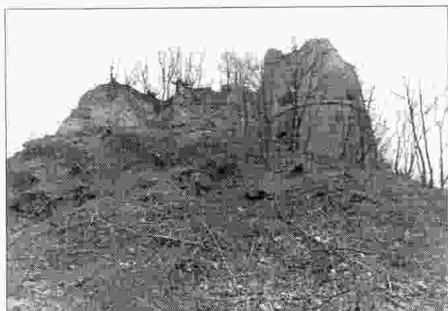
Sl. 10. Pogled s jugozapada na grad nakon sječe šume. Snimio Drago Miletić u ožujku 1995
