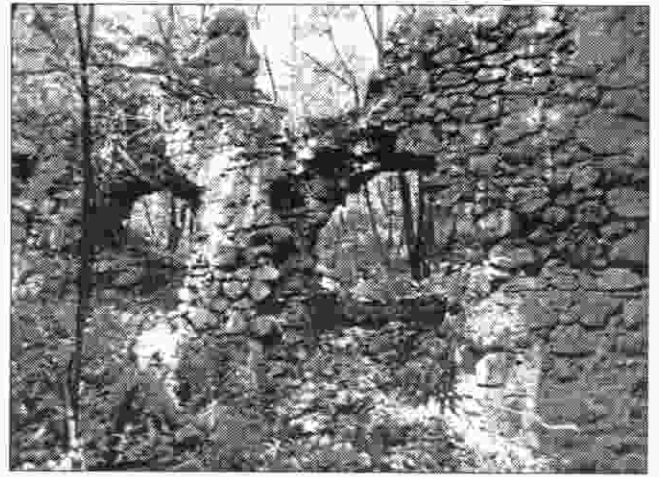
Sl. 24. Unutrašnjost baterijske polukule BK, pogled na sjeverni zid. Snimio Drago Miletić u kolovozu 1994. Abb. 24. Der Innenraum des Batterienhalbturmes BK, Blick auf die nördliche Mauer. Foto: D. Miletić, August 1994.
