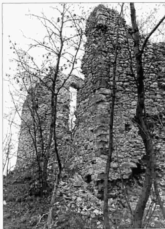
Sl. 26. Gradska jezgra, pogled s juga na zapadni zid. Snimio Drago Miletić u travnju 1992.
