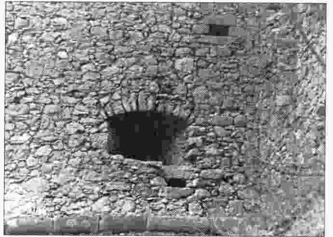
Sl. 25. Pogled izvana na istočne otvore baterijske polukule BK. Snimio Drago Miletić u ožujku 1995. Abb. 25. Blick von außen auf die östlichen Schießscharten des Batterienhalbturmes BK. Foto: D. Miletić, März 1995.
