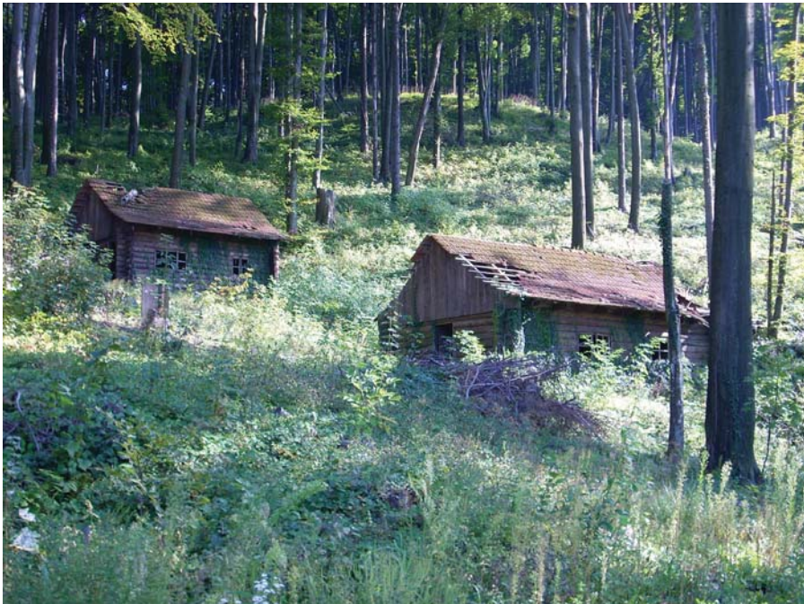
Sl. 1: Pogled na bolničke barake s ceste prije obnove
