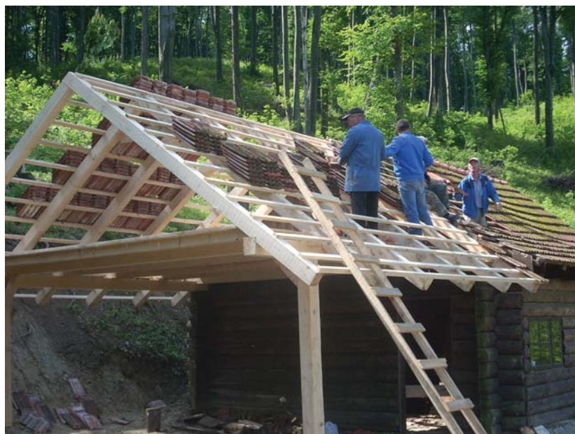
Sl. 6: Rekonstrukcija krovišta barake (Foto: M. Dretar)
