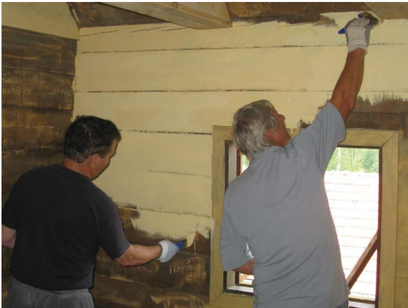
Sl. 8: Premazivanje unutrašnjih zidova
