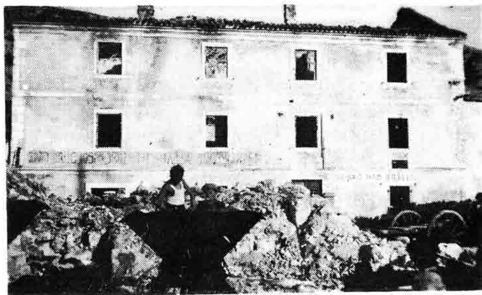
Sl. 91 — Uklanjanje ratnih ruševina i obnova Jurjeva 1945.
