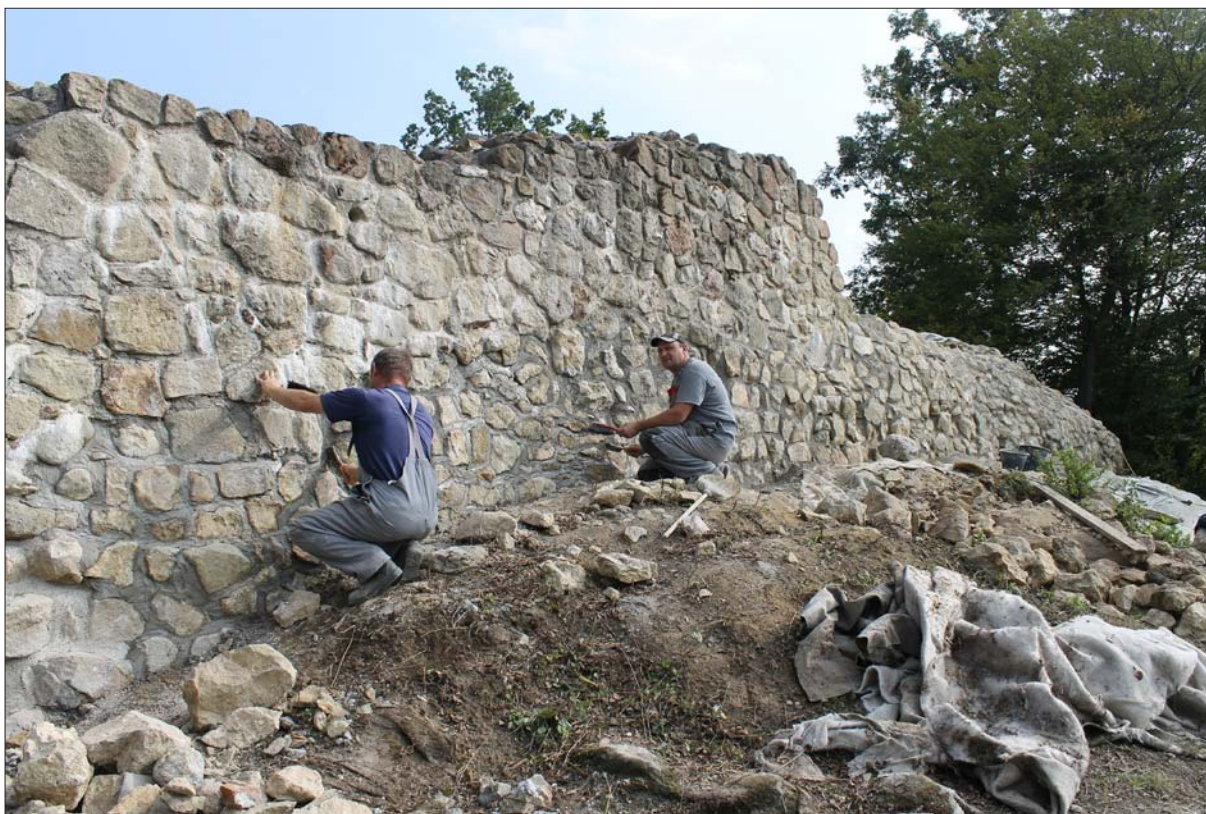
Sl. 5 Njegovanje žbuke, pogled na vanjsko lice zida SJ 062 od sjeverozapada (snimila: T. Tkalčec)
