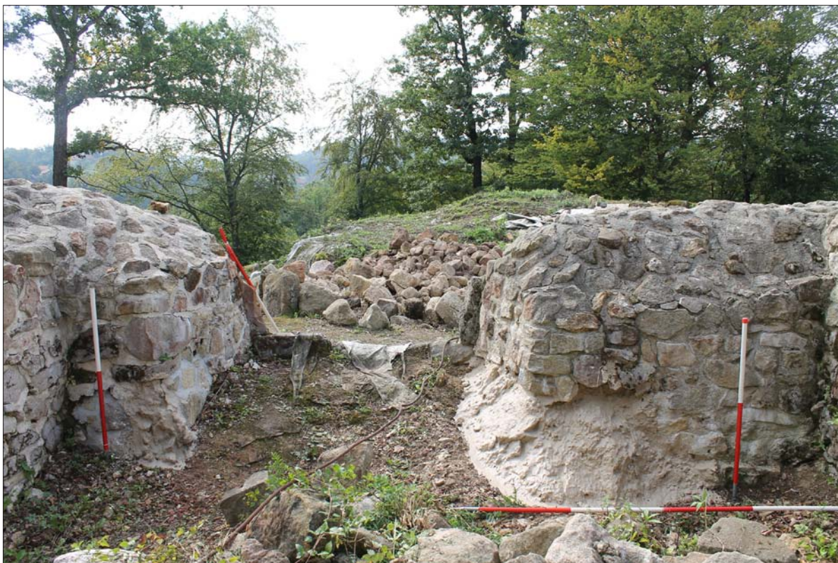
Sl. 8 Pogled od sjevera na unutrašnja lica zidova srednje prostorije palasa (kod praga SJ 028) – zalijevanje kamena živca vapnenim mlijekom (snimila: K. Jelinčić Vučković)
