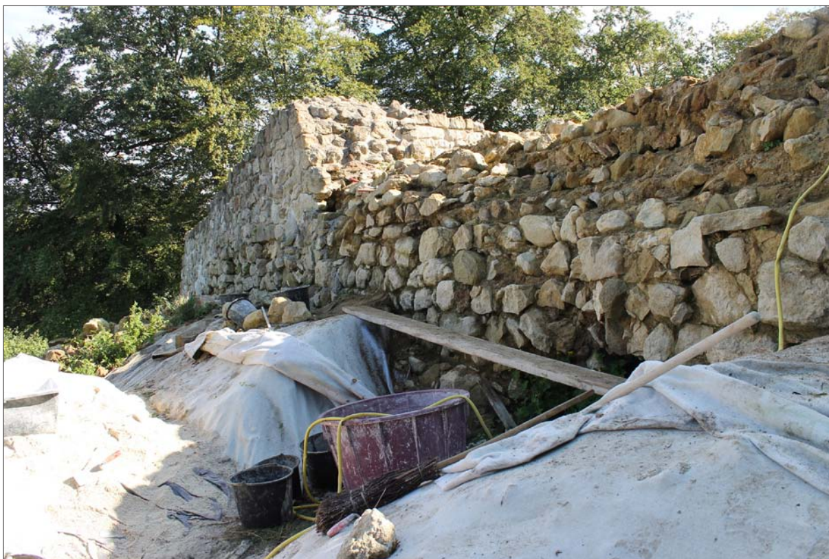
Sl. 1 Pogled od jugozapada na zapadni obodni zid burga prije zidarskih radova (lijevo: prethodno u gornjim dijelovima konzervirani segment SJ 062, desno; segment SJ 061) (snimila: T. Tkalčec)
