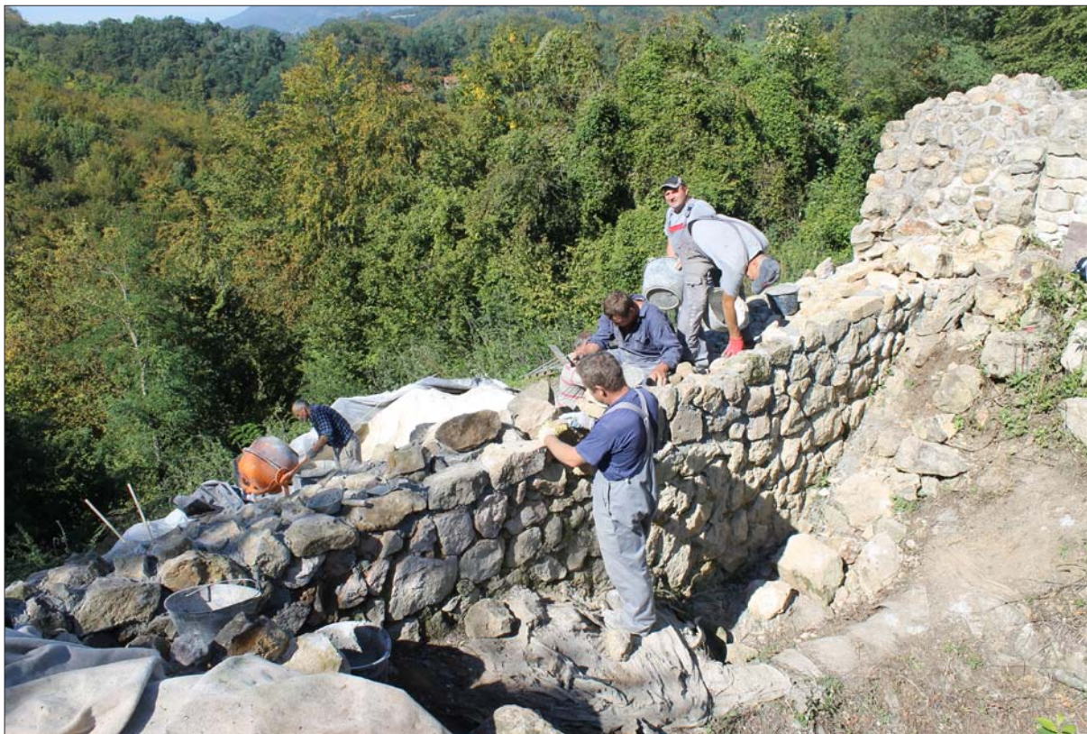
Sl. 3 Zidarski radovi, pogled na unutrašnje lice zida SJ 061 od jugoistoka (snimila: T. Tkalčec)
