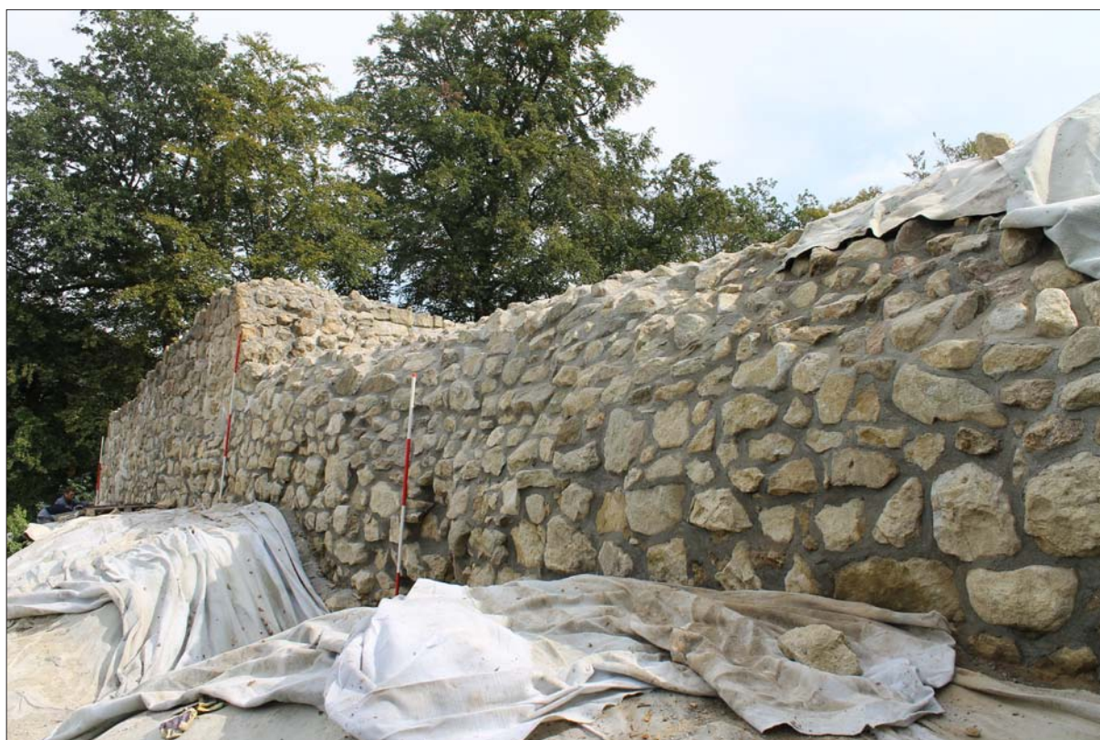
Sl. 6 Pogled na vanjsko lice zidova SJ 062 (lijevo) i SJ 061 (desno) od jugozapada nakon konzervatorskih radova; zaštita okolnih slojeva geotekstilom (snimila: K. Jelinčić Vučković)
