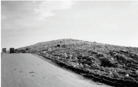
Slika 4. Odlagalište prije završetka sanacije, 2000. godina (Barčić 2010)
