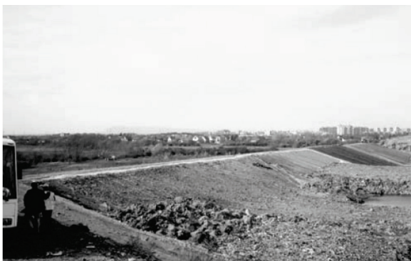
Slika 5. Radovi na sanaciji odlagališta (Barčić 2010)
