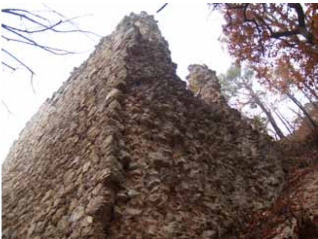
10 Pogled na južni i istočni zid kapele utvrde Grebengrad izvana, stanje 2012. (foto: M. Korunek)
