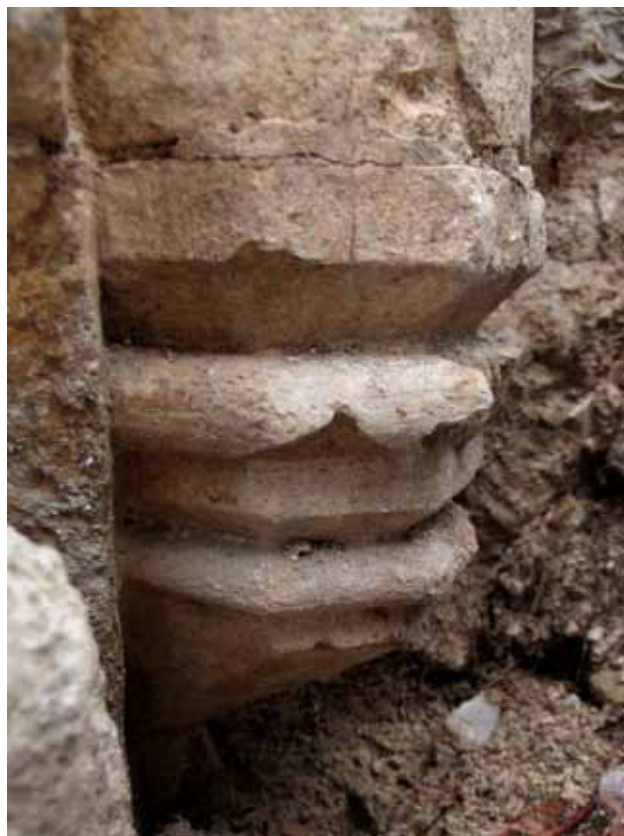
12 Konzola koja nosi polustup (službu) na spoju južnog i istočnog zida svetišta u unutrašnjosti kapele utvrde Grebengrad (foto: M. Korunek)
