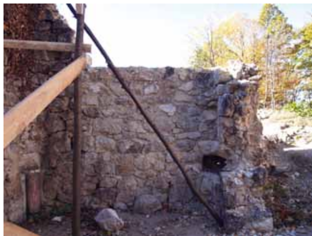
20 Zapadni zid svetišta kapele utvrde Grebengrad u tijeku sanacije 2012. (foto: M. Korunek)
