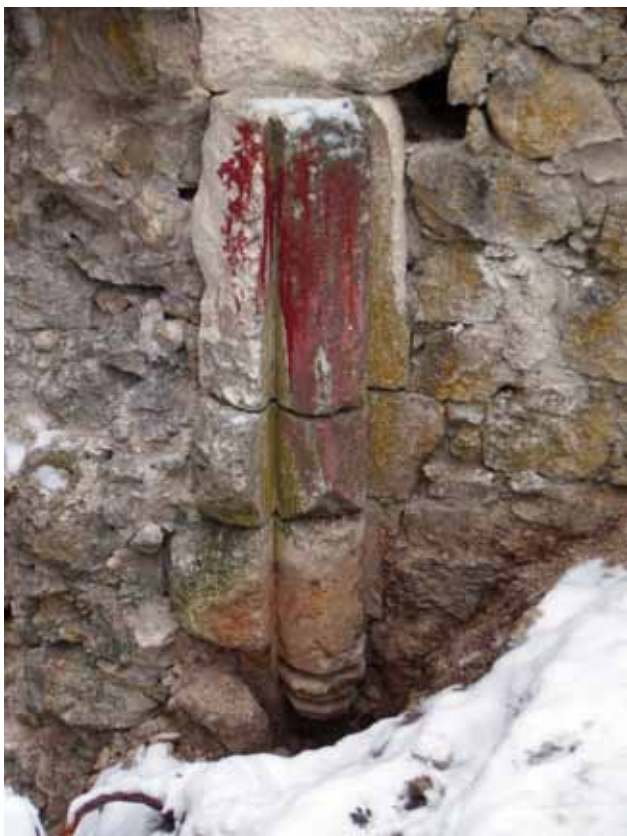
11 Polustup (služba) koji nosi konzola na spoju južnog i istočnog zida svetišta u unutrašnjosti kapele utvrde Grebengrad (foto: M. Korunek)
