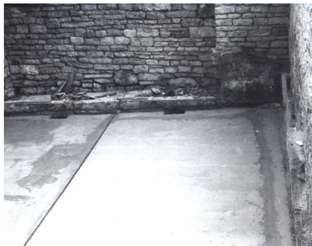
Sl. 5 Nova cementna podloga i odvodi vode za budući mozaik (Fototeka AMI-ja, fotonegativ 25873).
