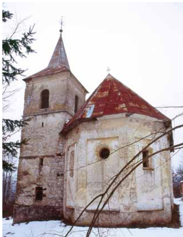
3 Pročelja svetišta kapele sv. Franje Ksaverskog (fototeka HRZ, foto: D. Miletić, 2006.)
