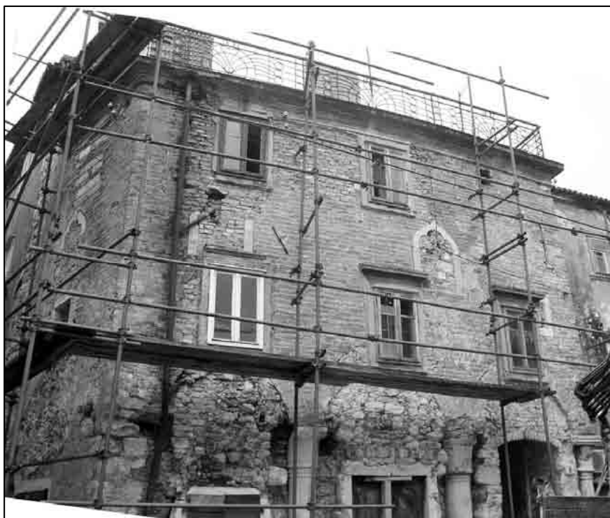
Sl. 13. Pročelje lože nakon uklanjanja žbuke (foto-arhiva GMS)
