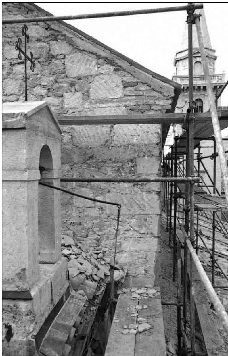
Sl. 37. a-b; Radovi na južnom i istočnom zidu katedrale (foto-arhiva Konzervatorskog odjela Rijeka)
