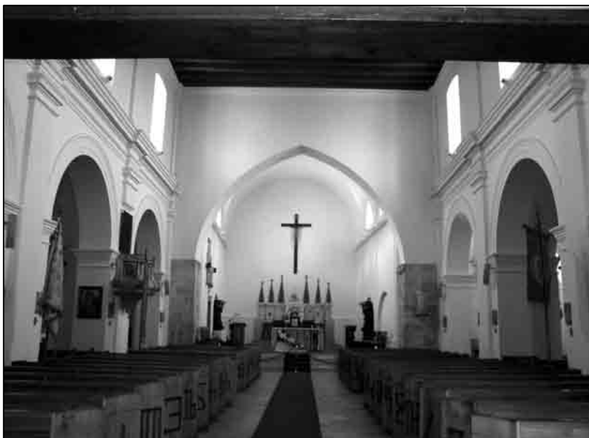
Sl. 40. a-b; Pročelje i unutrašnjost katedrale nakon svih dosadašnjih obnova (foto-arhiva Konzervatorskog odjela Rijeka i GMS)
