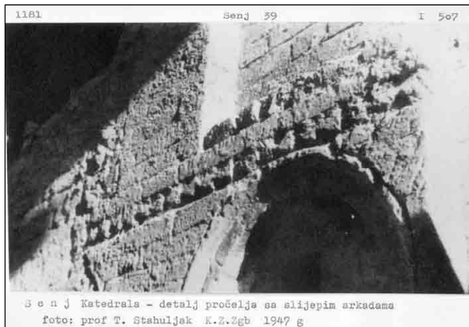
Sl. 16. a, b i c. Pročelje katedrale sa slijepim arkadama nakon skidanja žbuke (foto-arhiva Konzervatorskog odjela Rijeka)
