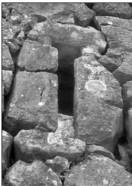
Sl. 30. Štulića klina, puškarnica u vanjskom zidu (foto: A. Birin, 2013.)
