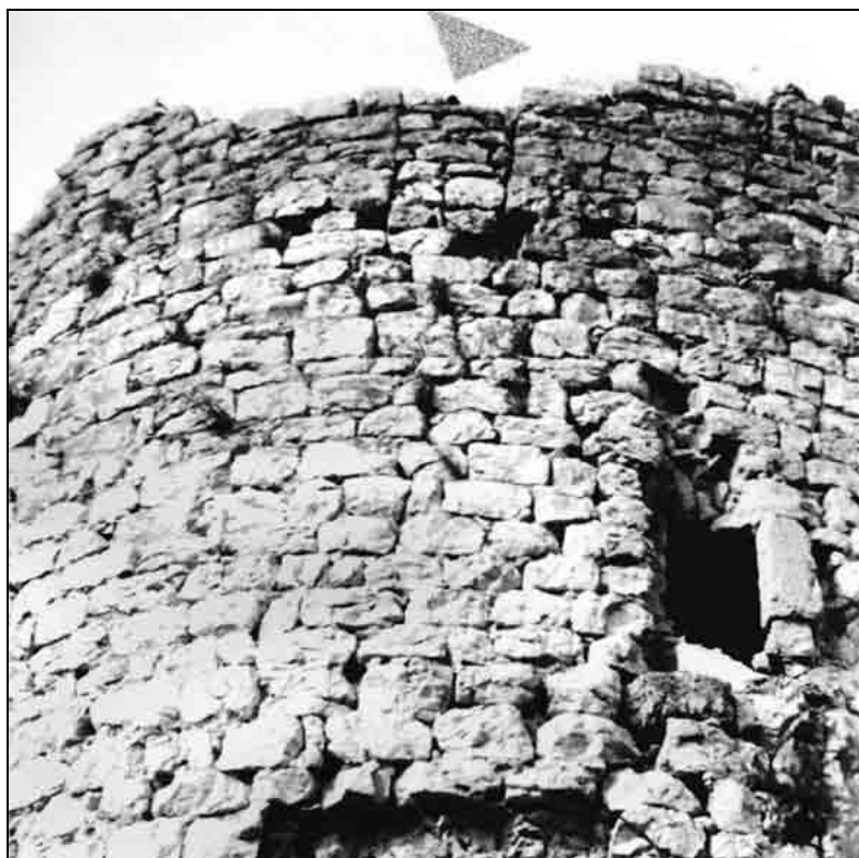
Sl. 22. Perušić, vrh branič-kule: uočiti zazidani otvor na vrhu kule (foto: Z. Horvat, 1993.)
