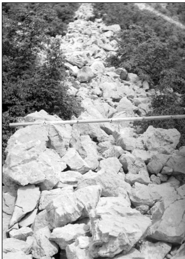
Sl. 5. Dolabelin međašni zid između Stinice i Jablanca – detalj na duljini 220 m od morske obale, širina zida oko 1,60 m (foto: Aleksandra Faber 1964.)
