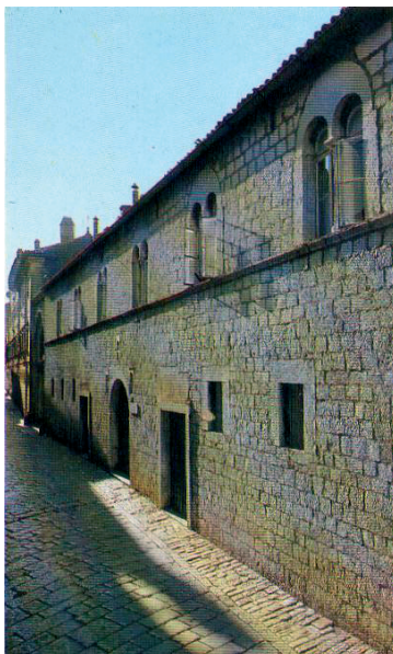
Kanonička kuća u Poreču (1271), monumentalni je spomenik stambene arhitekture romanike: zatvoreno prizemlje s malim prozorima služi za konobe i spremišta, a na prvom katu nižu se velike mramorne bifore soba za stanovanje.
