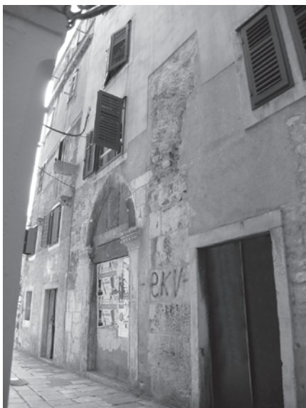
Slika 6. Ostaci pilona i lukova na sjevernom pročelju prije njegovog žbukanja (Arhiv Mediteranskog centra za graditeljsko naslijeđe u Splitu)
