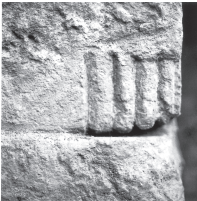
Sl. 10 Spolij u temelju kontrafora 3 na sjevernoj strani broda, nejasne namjene; moguće se radi o dijelu nadvratnika (foto: M. Visin, 1999.)
