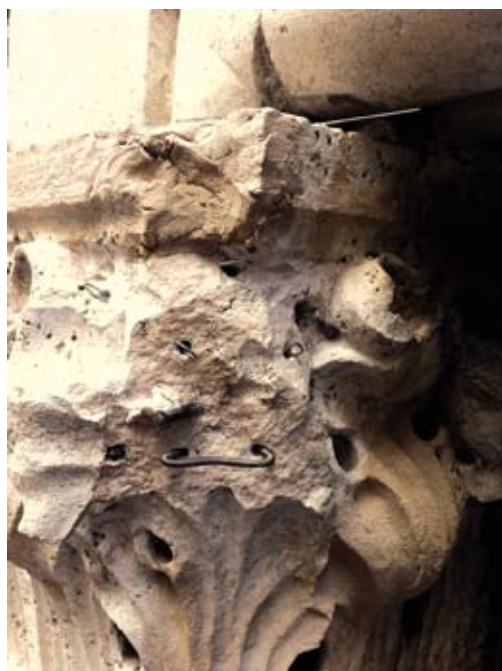
Umjesto uklonjene cementne rekonstrukcije postavljeni nehrđajući ankeri na mjestu buduće rekonstrukcije
