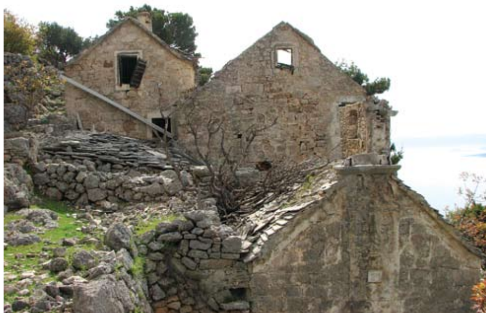
Pogled sa sjeverozapada na crkvu, kuće B i C
