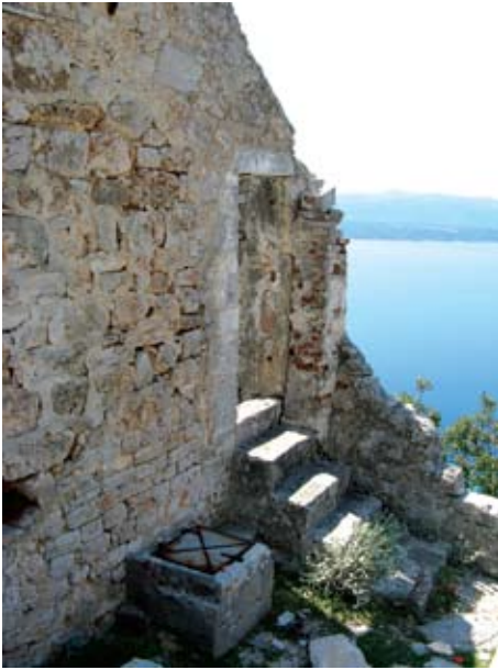
Cisterna između crkve i kuće A
