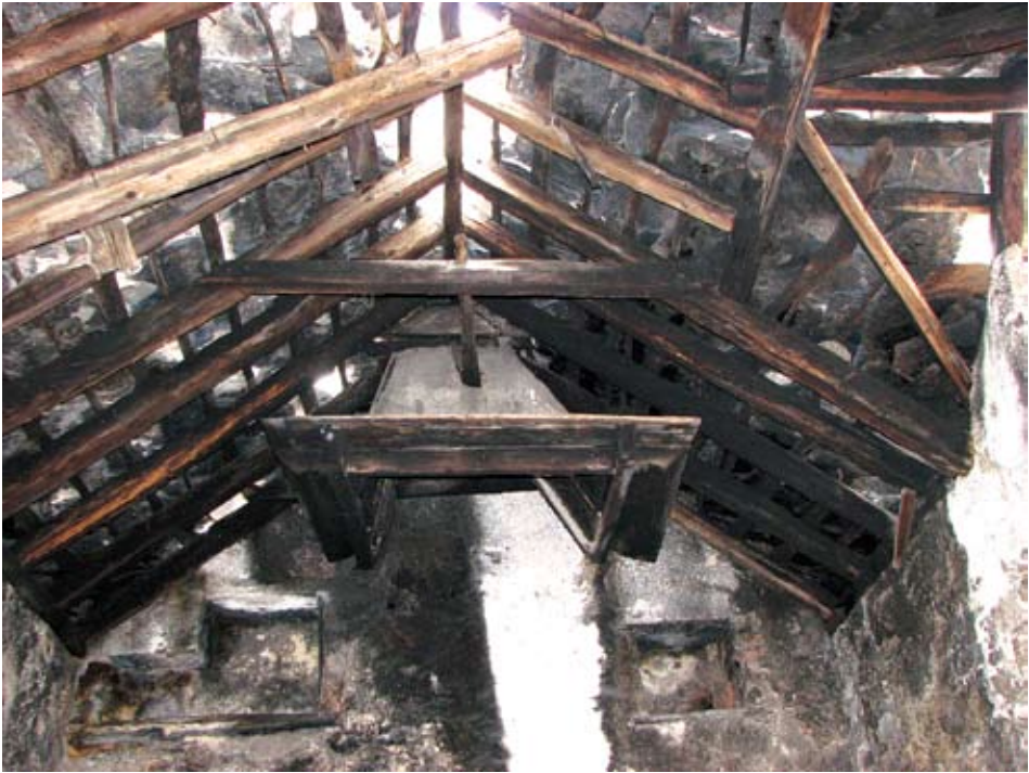
Drvena konstrukcija krova i komin u gornjoj kuhinji kuće B
