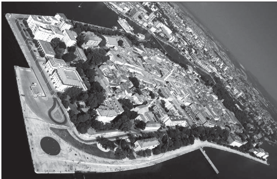
Slika 16. Pogled iz zraka na povijesnu jezgru Zadra s Požgajevim zgradama na Novoj rivi, foto M. Gospić.
