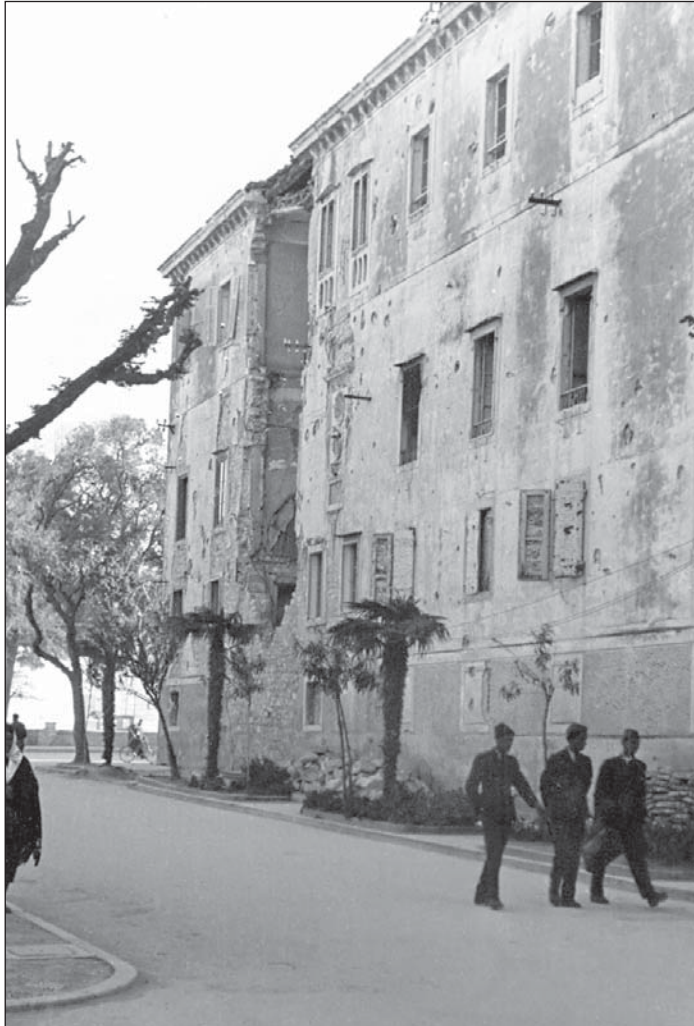
Slika 2 a. Oštećena zgrada Providurove palače, snimio Harold Bilinić, 1946. god.; AMKRH, fototeka inv. br.: 52098.
