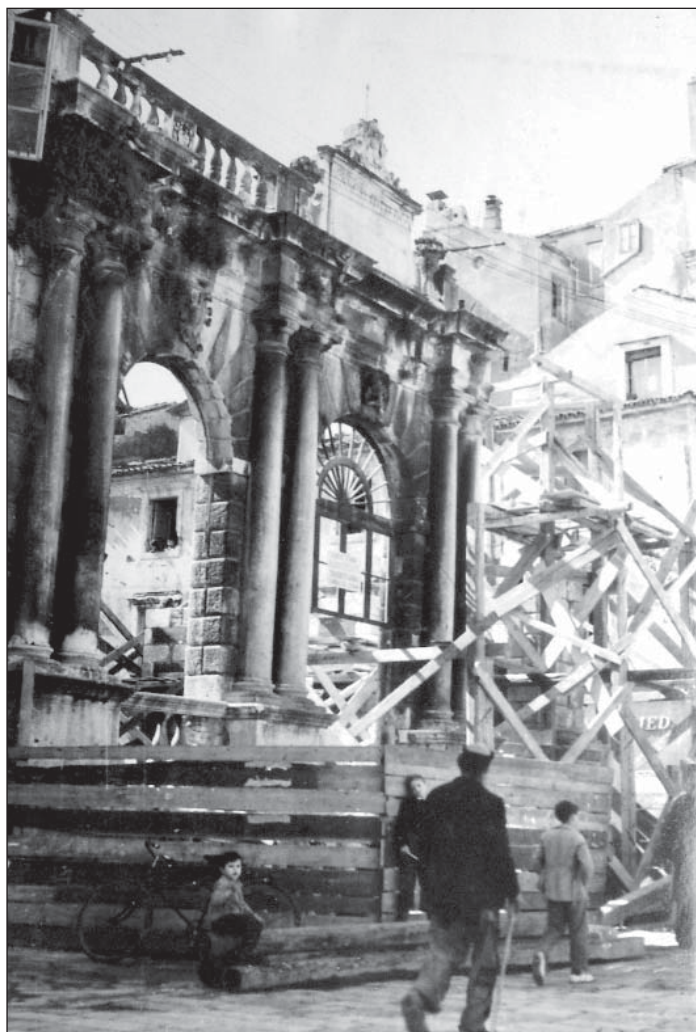
Slika 1a. Gradska loža s demontiranim zidom prema ulici i prema Narodnom trgu, AKOST/AKOD.
