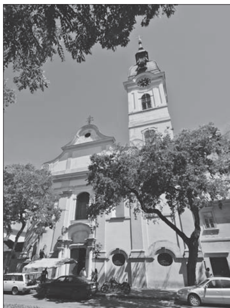
FIG. 13. THE HOLY TRINITY CHURCH AT THE FORMER FRANCISCAN MONASTERY IN SOMBOR (1752-62) SL. 13. CRKVA PRESVETOG TROJSTVA U BIVŠEMU FRANJEVAČKOM SAMOSTANSKOM SKLOPU U SOMBORU (1752.-1762.)
