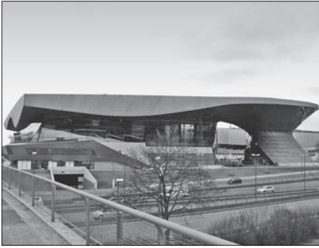
FIG. 2. BMW WELT MUNICH, GERMANY, PHOTOS 2008: VIEW FROM BRIDGE TO OLYMPIA STADIUM PARK SL. 2. BMW WELT, MÜNCHEN, NJEMAČKA, SNIMLJENO 2008.: POGLED S MOSTA NA PARK OLIMPIJSKOG STADIONA
