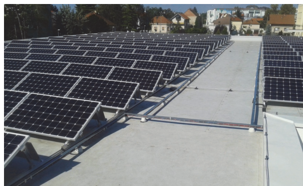
Slika 8. Prikaz izvedbe ožičenja i povezivanja stringova na krovu objekta
