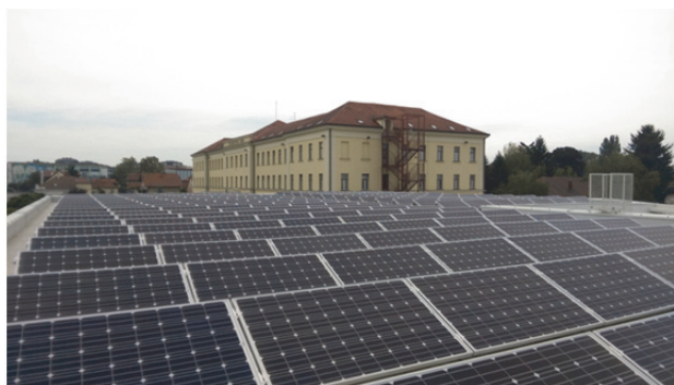
Slika 1. Prikaz montiranih panela na krovu
