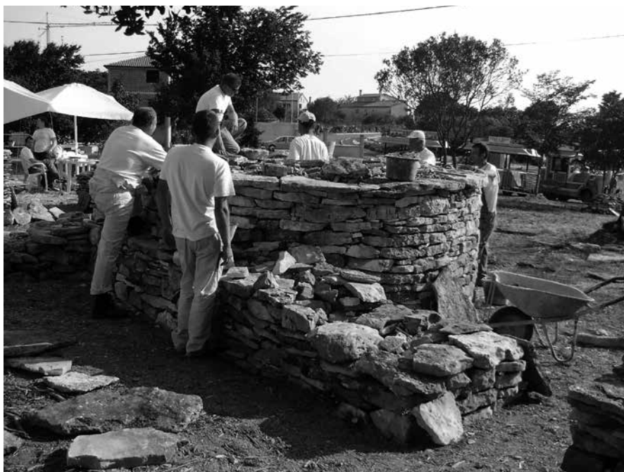
Sl. 9. Galižana, gradnja kažuna
