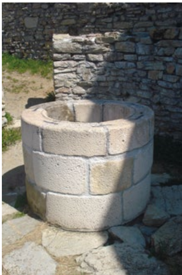
14. Kruna vodospreme rekonstruirana je s tri reda isklesanog prirodnog i umjetnog kamena, a elementi najgornjeg reda spojeni su brončanim skobama (snimio H. Malinar).
