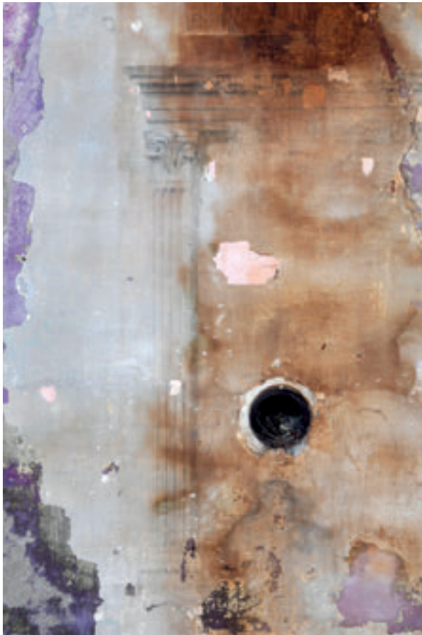
20. Detalj zidnog oslika sjeveroistočne prostorije (prostorija 2) na katu – naslikana napa kamina (snimila N. Vasić, Hrvatski restauratorski zavod).
