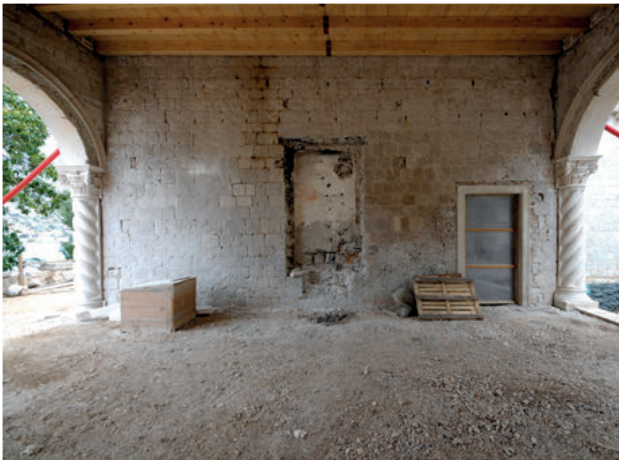
24a. Nalaz zidnog umivaonika iz 16. stoljeća na istočnom zidu lode (snimila N. Vasić, Hrvatski restauratorski zavod). 16 th -century wash basin discovered on the eastern wall of the loggia (photo by N. Vasić, Croatian Conservation Institute)
